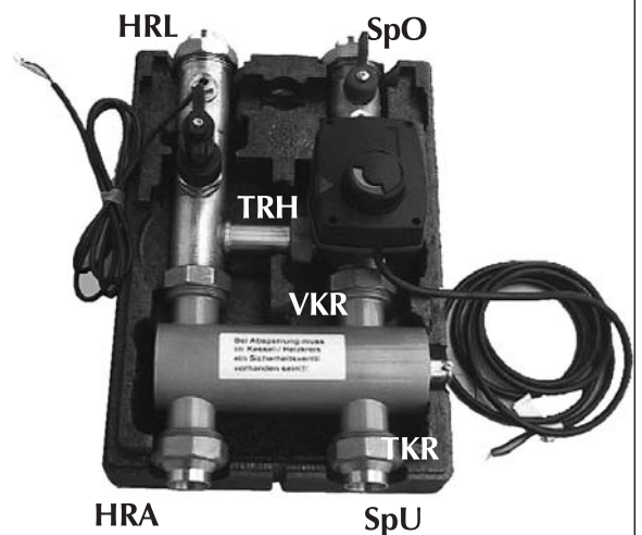
Armaturenblock aus Messing mit Dreiwegemischer und Mischermotor,
